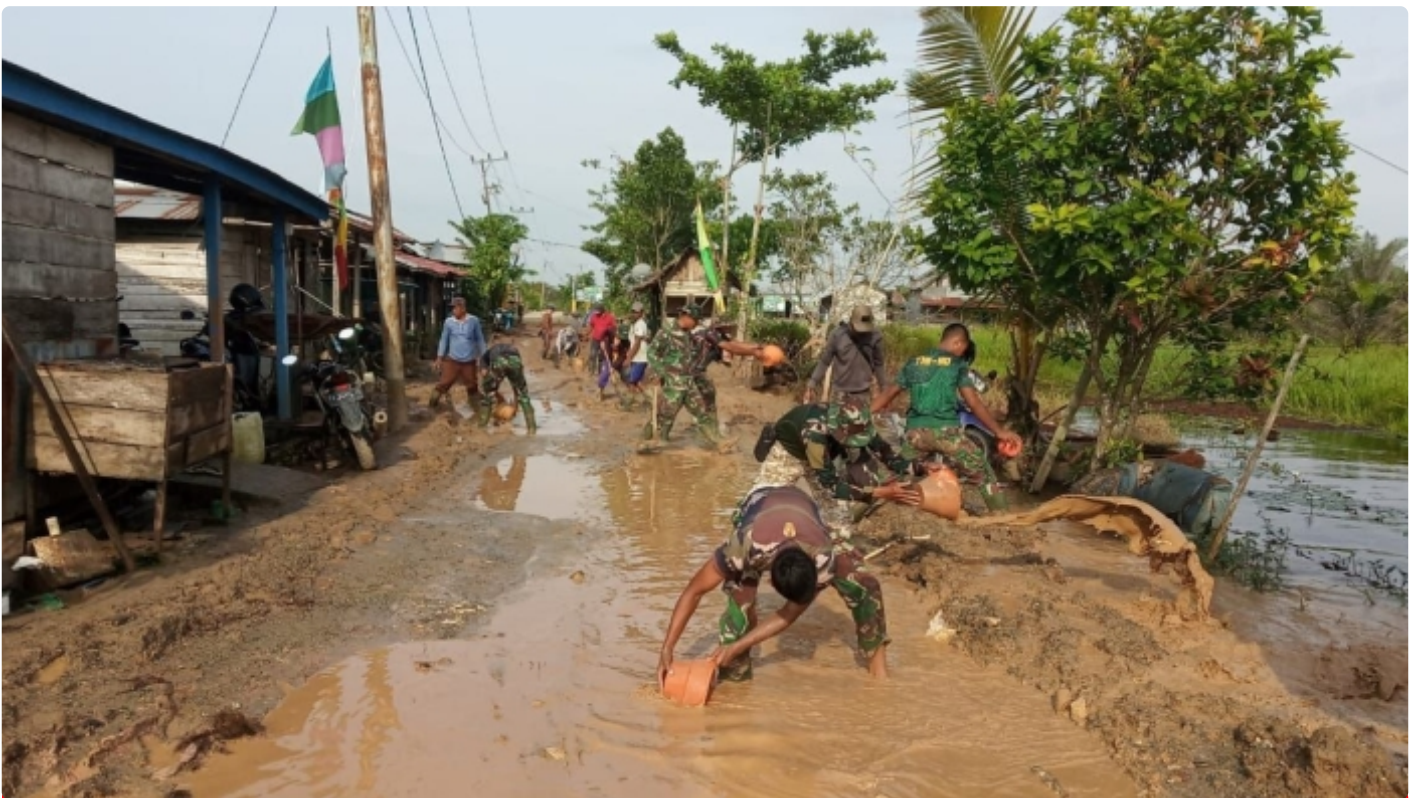
Personel Satgas TMMMD Kuras Kubangan Lumpur Demi Percepatan Pengecoran Jalan
